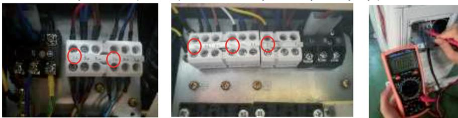
3) Если напряжение между клеммами 1A, 1B, 1C, 1D и N, присоединенных к внутреннему блоку, в норме, измерьте напряжение между клеммами 1 и N наружного блока. Если это напряжение изменяется в диапазоне 0–12 В (изменяющееся импульсное напряжение), но напряжение 24 В отсутствует, замените печатную плату наружного блока.
