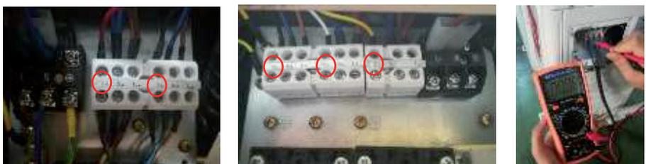
4) Если напряжение между клеммами 1, 1A, 1B, 1C, 1D и N в норме, измерьте напряжение между клеммами 1 и N наружного блока. Если напряжение не изменяется, сначала замените главную печатную плату внутреннего блока. Если неисправность не устранена, замените печатную плату наружного блока.
