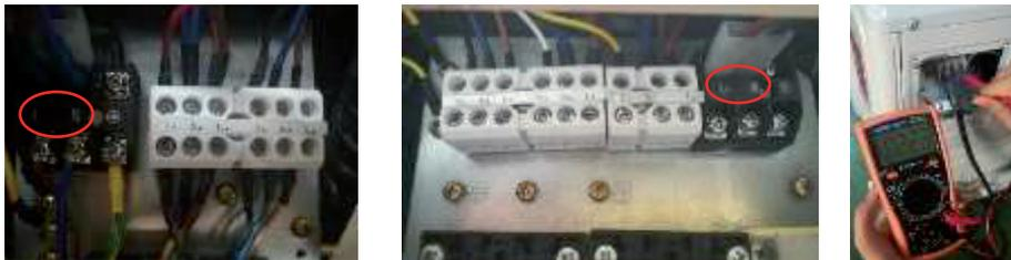
2) Если напряжение между клеммами 1 и N, присоединенных к внутреннему блоку, в норме, измерьте напряжение между клеммами 1A, 1B, 1C, 1D и N наружного блока. Если это напряжение изменяется в диапазоне 0–24 В (изменяющееся импульсное напряжение), замените главную печатную плату внутреннего блока.
